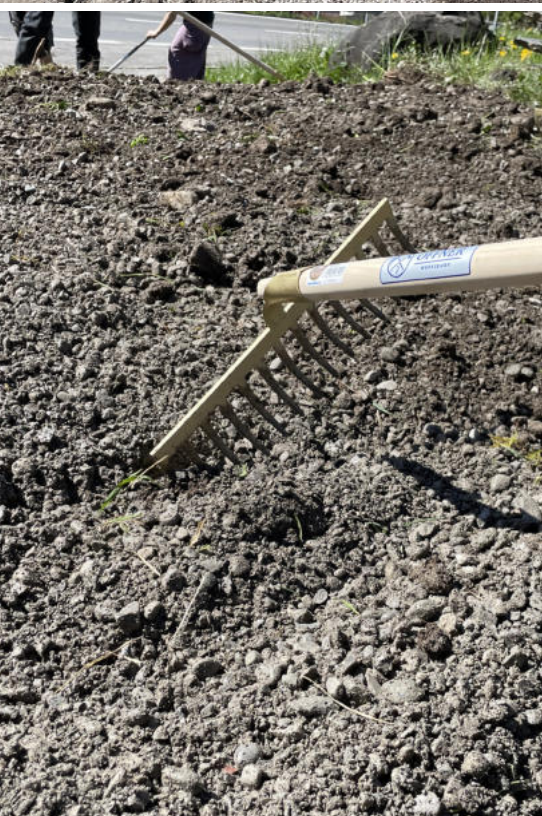
Einebnen des neu aufgetragenen Materials mit dem Rechen
