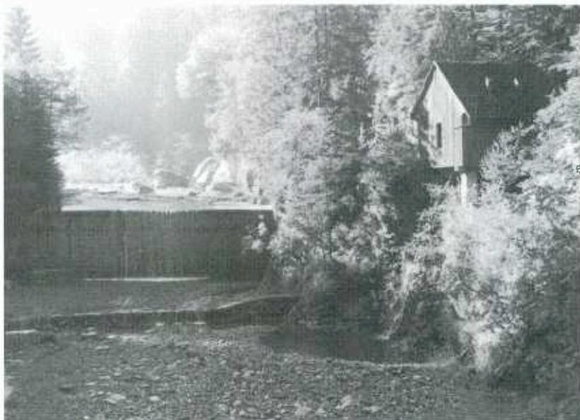
*Das Hauptgerinne der Frutz bei den »oberen Läden«. Hinter dem breiten Wasserfall stand der Abweisrechen, der das Holz in den Triftkanal lenkte. Der Wasserfall rechts dient der Entlastung des Triftkanals bei Hochwasser oder als Ableitung, wenn der Triftkanal trocken gelegt wird.*
