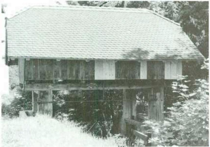
Die unteren Läden mit der Leerlauffalle rechts. Links befindet sich die Falle für den Umlauf des Mühlbaches.
