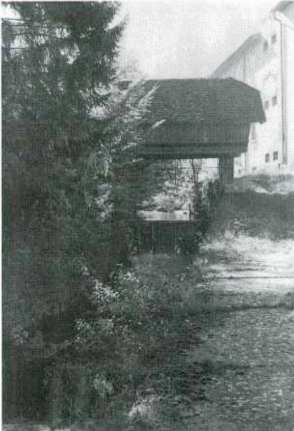
*Die »unteren Läden« neben der Spinnerei Rhomberg dienen der Ableitung von Überwasser nach links oder der Einleitung des Notwassers für den Mühlbach nach rechts.*
