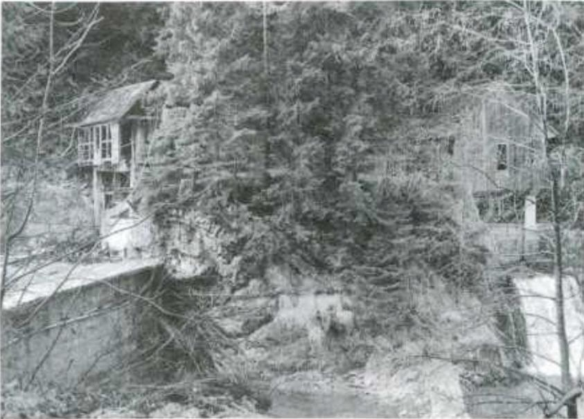
Das vordere Hochwahr, darüber das halb verfallene Eichenhaus am Eingang in die ausgesprengte Felsschlucht. Rechts die oberen Läden bei geöffneter Leerlaufalle. Die Wasserleitung unter der „Bädera“ gehört zur ehemaligen Brauerei Fulterer.
