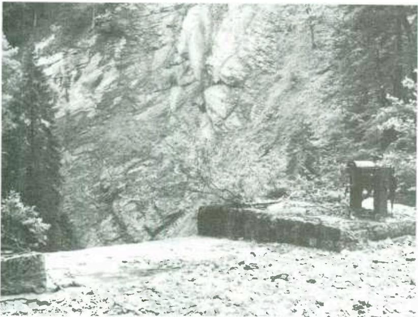
*Die verlandete Mauerkrone der Wasserstube mit dem Getriebe des Leerschütz.*
