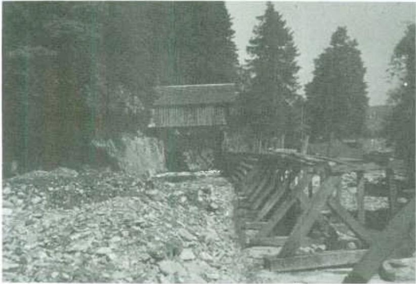
*Der Abweisrechen, »Böcke« genannt (gerade in Reparatur), leitet das Flözholz in den Flözkanal, der bei den »Eichen« (unter der Hütte) beginnt. Das Überwasser fließt durch die Böcke in das Hauptgerinne der Frutz (Muntliger Bach).*
