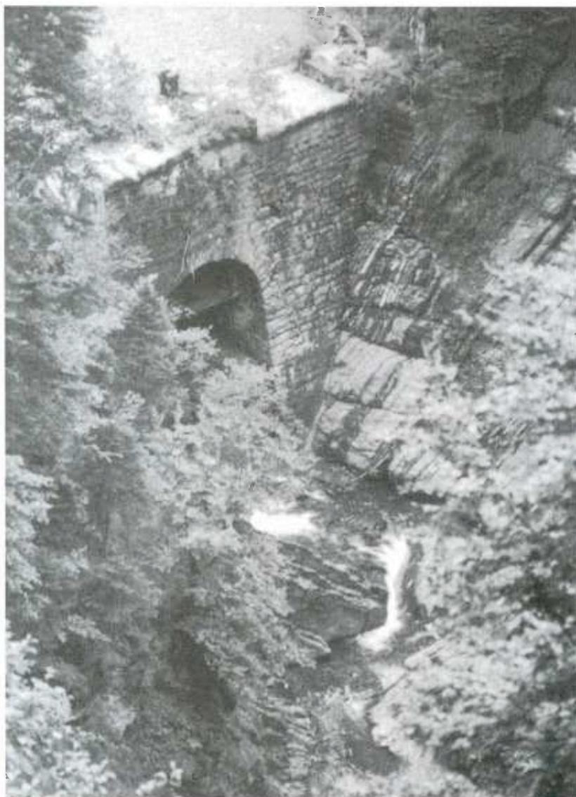
*Die Wasserstube im Frödischtal mit dem Klaustor. Links neben dem Überlauf ist das Getriebe für den Leerschütz sichtbar. Der Klaushof dahinter ist verlandet.*
