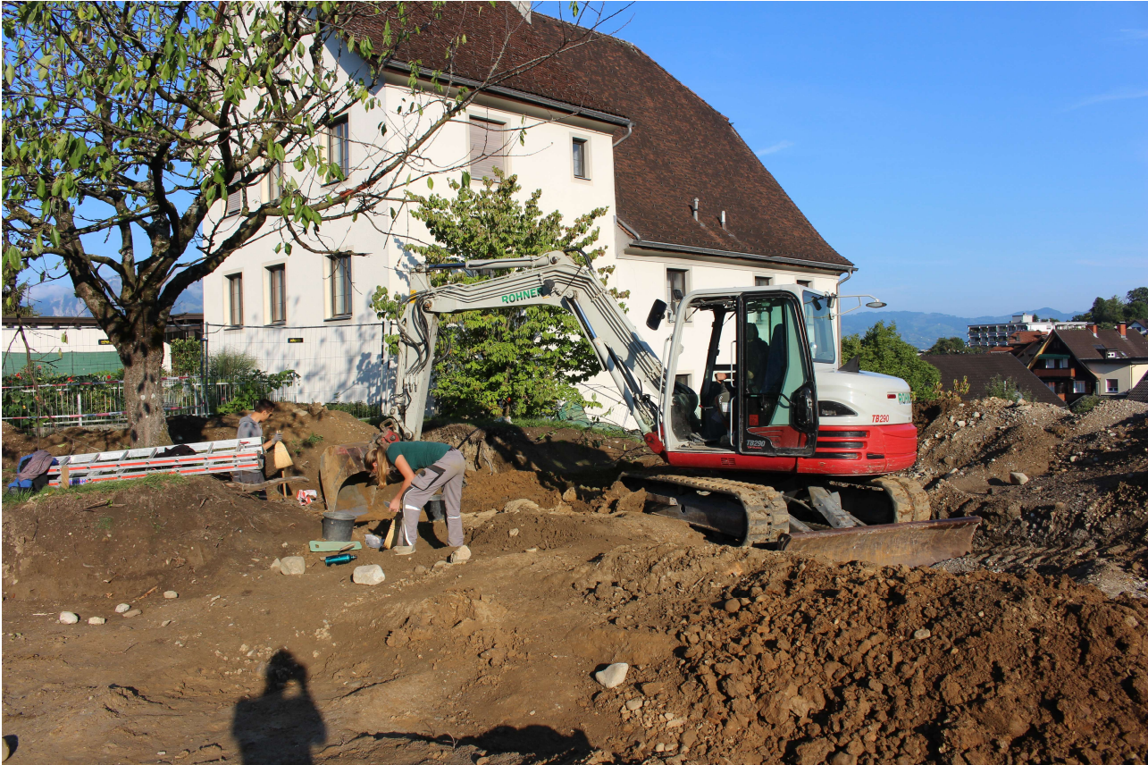
Abb.5: Foto TALPA. Freilegen der Gräber mit Hilfe eines Baggers.
