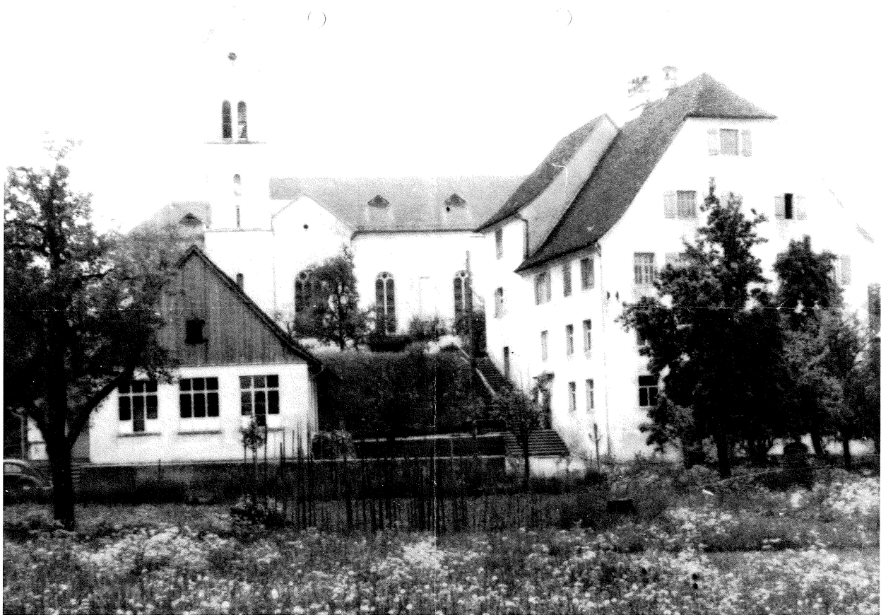
Abb.2: Scann Gemeinde. Im Hintergrund die Kirche, rechts der noch bestehende Ansitz, links im Bild das ca.1975 Wirtschaftsgebäude, welches eine Zeit lang als Schulhaus verwendet wurde. Am gleichen Platz wurde der neue Kindercampus von der Gemeinde geplant.
