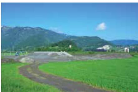
Auf öffentlichem Wassergut im Gemeindegebiet von Meiningen wurde ein Versuchsdamm für das Wasserschutzprojekt RHESI errichtet. Am Versuchsdamm wird das Langzeitverhalten des Materials sowie die Begrünung beobachtet. In noch nicht festgelegter Zeit wird der Damm wieder abgetragen und das Gelände rekultiviert.
