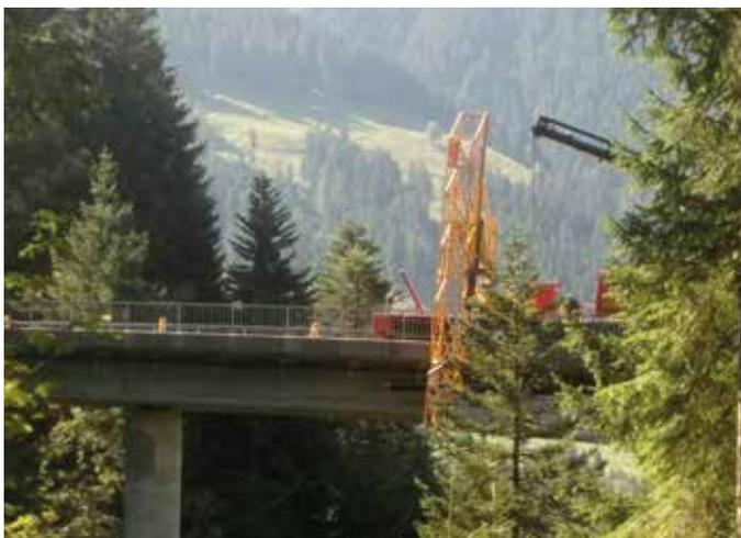
Anbringung der Trink- und Löschwasserleitung an der Brücke Sägetobel
