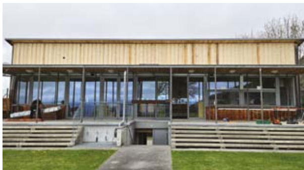
Mit enormem, ehrenamtlichem Einsatz wurde die Solaranlage des Clubheims saniert.
