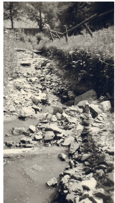
Der alte Morgengabeweg nach der Unwetterkatastrophe.
